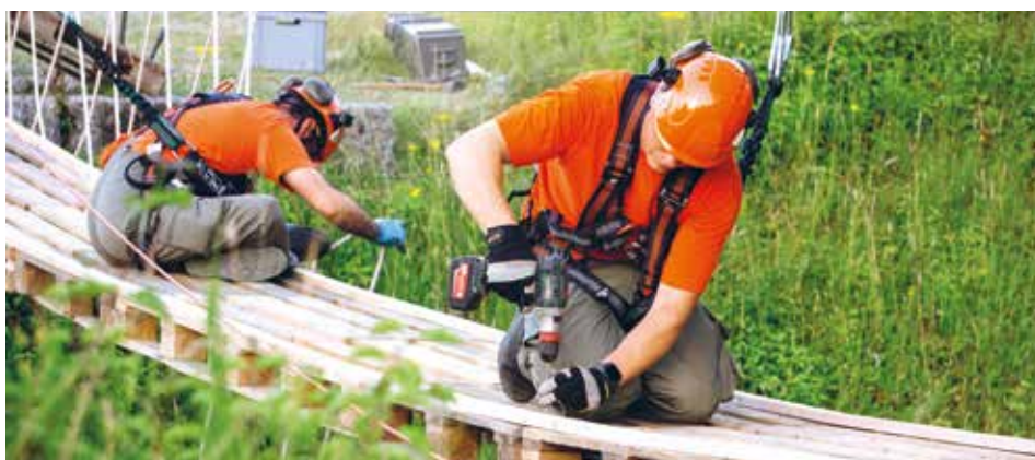
Aufbau einer provisorischen Fussgängerbrücke.
