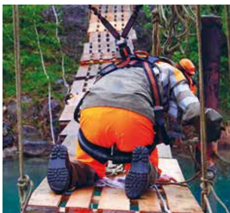
Für die Evakuierung wurde eine Hängebrücke erstellt.
