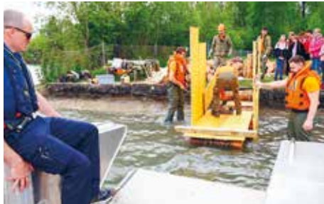
Erstellen des Landungssteges.
