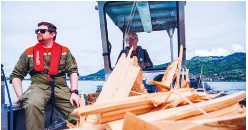
In erster Priorität galt es, die massive Menge Schwemmholz wegzuräumen.
