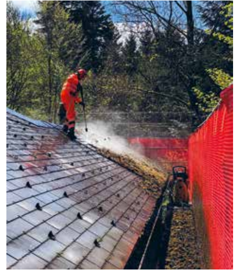
Ein Zivilschützer befreit das Dach von Moos.
