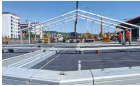
Avant : les fondations et l'échafaudage pour les tentes VIP à l'extérieur sont construits.
