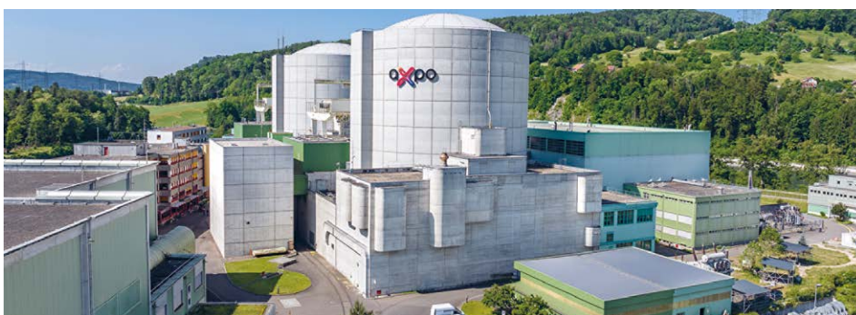
Übungsort der Sonderlage war das Kernkraftwerk Beznau.
