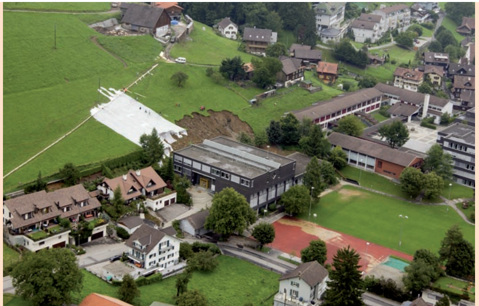
1500 M 3 DE BOUE ET D'ÉBOULIS ENVAHISSENT LA COUR DE RÉCRÉATION.
